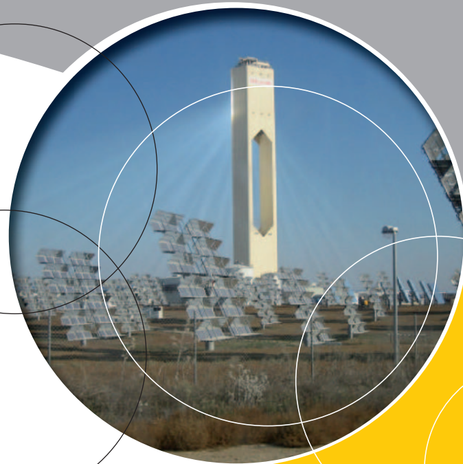
Torre propiedad de Abengoa Solar
